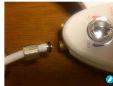
シャワートイレ本体の位置に合わせて、給水・給湯用ホースの長さを決めてくる。本体/ホース説明金具を装着しキャップで本体に締め込む。
